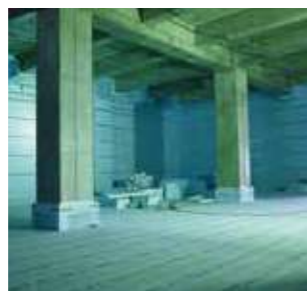
冷凍倉庫 防熱工事 事例
