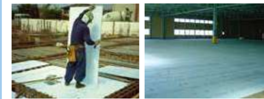
ピットワーク™(型枠兼用) ドマフォーム™(防湿フィルム付き)
